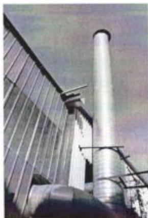
图 6. 喷涂工序废气排气筒
