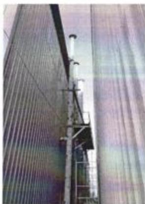
图 8. 焊接、打磨工序废气排气筒（右 1）
