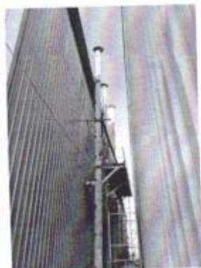
图 1. 生物质炉废气排气筒（中）
