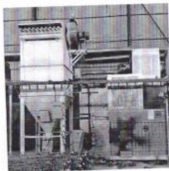
图 2. 生物质炉废气布袋除尘器
