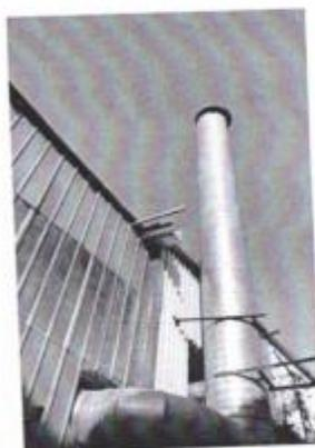
图 3. 天然气废气、固化工序排气筒
