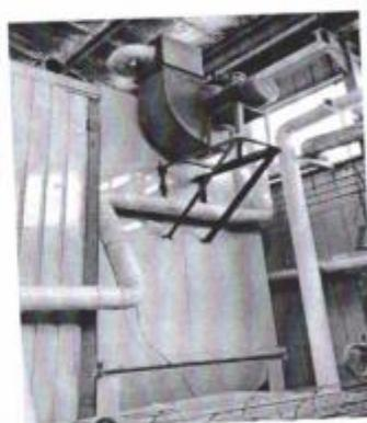
图 4. 天然气废气、固化工序布袋除尘器
