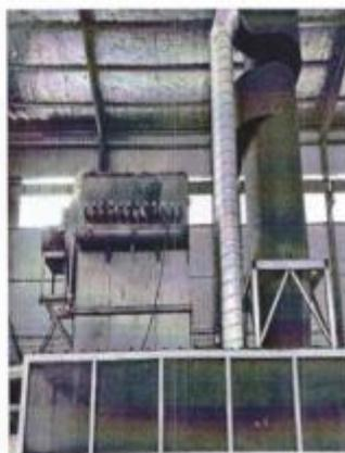
图 7. 喷涂工序布袋除尘器
